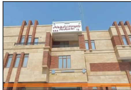
تجهیز و راه‌اندازی ساختمان ستاد اورژانس ۱۱۵ استان
