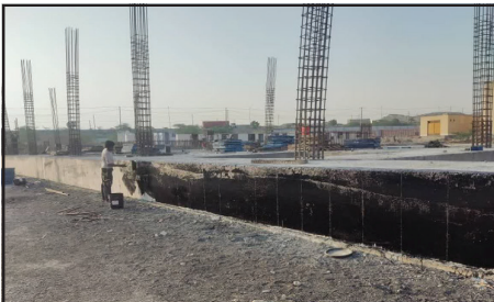
شروع ساخت ۱۷۲ واحد خوابگاه دانشجویان متأهل
