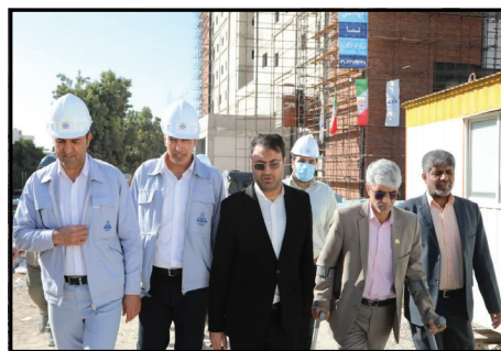
۱۵۵ پروژه عمرانی در دست احداث حوزه بهداشت و درمان و قابلیت اتمام تا پایان سال ۱۴۰۳
